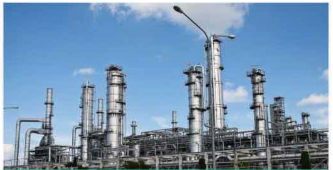
Ирак Salah - Электростанция Aldeen 2X630MW
