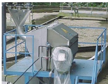
Муниципальный: GP 1500 Размер ячейки 0,75 мм Расход: 135 м 3 /ч
