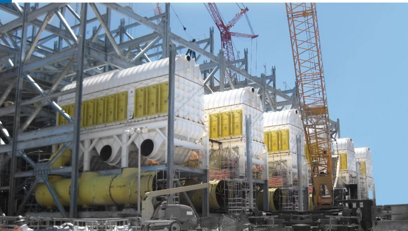
Термическая сушка угля позволяет повысить его теплотворные свойства и облегчить его транспортировку. Сушильные аппараты кипящего слоя производства компании ANDRITZ SEPARATION используют проверенную и безопасную технологию сушки угля.
