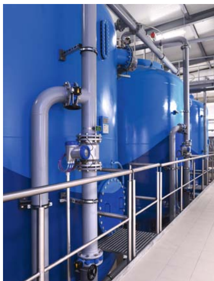
Установка для смягчения воды
