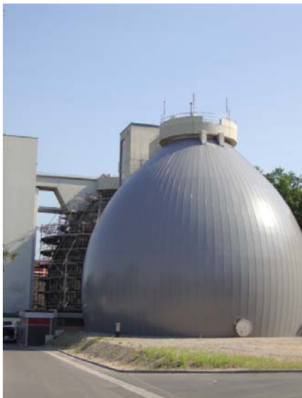
Метантенк. Источник: Dahlem Beratende Ingenieure
