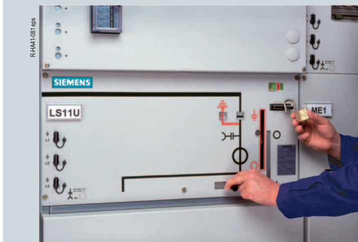
Запирающее устройство привода с помощью вставного рычага Пример: висячий замок
