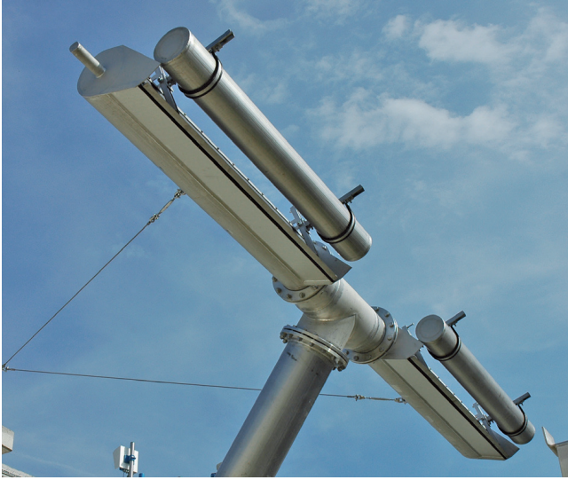
Труба забора очищенной воды декантера SBR-DEKA
